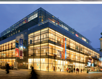
PASSAGE LINZ mit allen Unternehmen Landstraße 17-25
